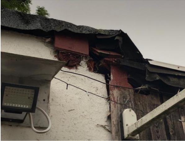
**Abb.8: Spalten an Dach**
