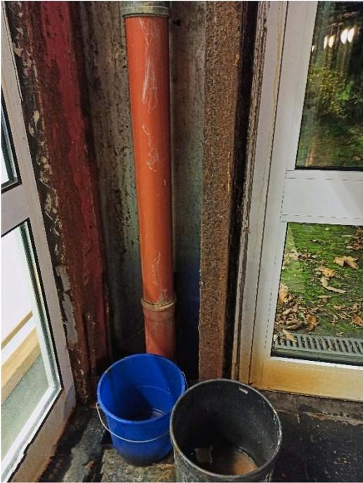
Bei Regenperioden wird das eindringende Wasser durch bereitgestellte Eimer aufgefangen. Außerdem wird hier sichtbar, dass der Kunststoff der Türen und Fenster unter dem Flugrost leidet.
