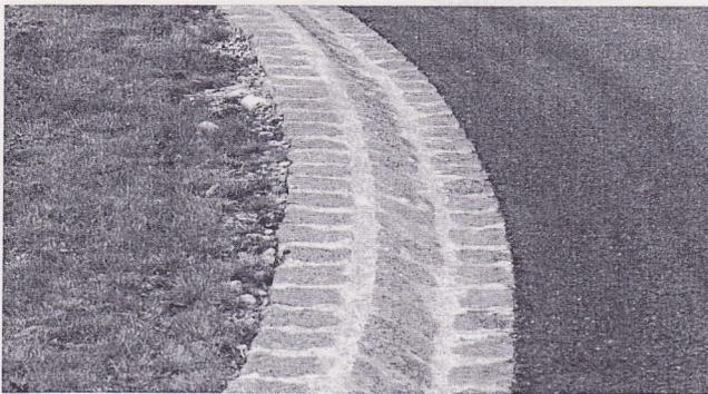
Bild 58: Beispiel für die Einfassung der Kreisinsel mit Natursteinpflaster
