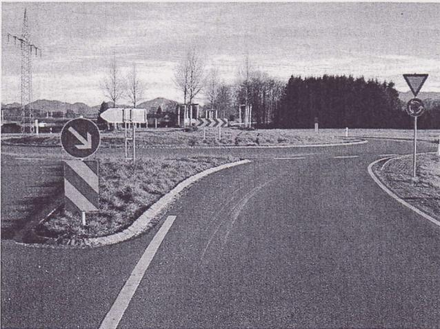
Bild 62: Beispiel für einen dem Fahrverlauf angepassten Fahrbannteiler an einem Kreisverkehr außerhalb bebauter Gebiete
