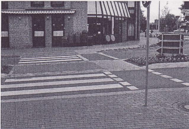
Bild 61: Beispiel für einen Fahrbannteiler innerhalb bebauter Gebiete
