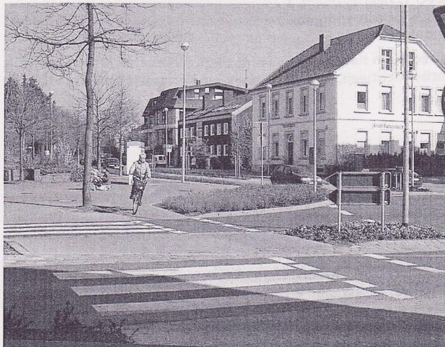
**Bild 38: Radverkehrsführung mit abgesetztem Radweg**
