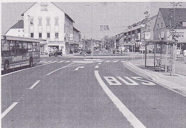
**Bild 43: Bussonderfahrstreifen bei einstreifiger Kreiszufahrt. Der Fahrstreifen für den Kraftfahrzeugverkehr wird mit dem Bussonderfahrstreifen zusammengeführt**
