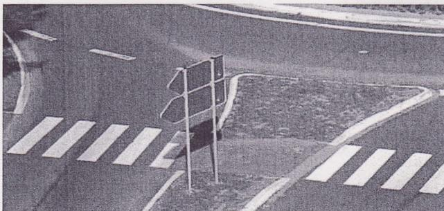
**Bild 31: Fahrbahnteiler mit Pfeilwegweiser hinter der Überquerungsstelle**
