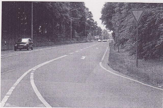
**Bild 22: Zusammenführung von Knotenpunktausfahrt und Bypass mit kurzem Einfädelungstreifen**
