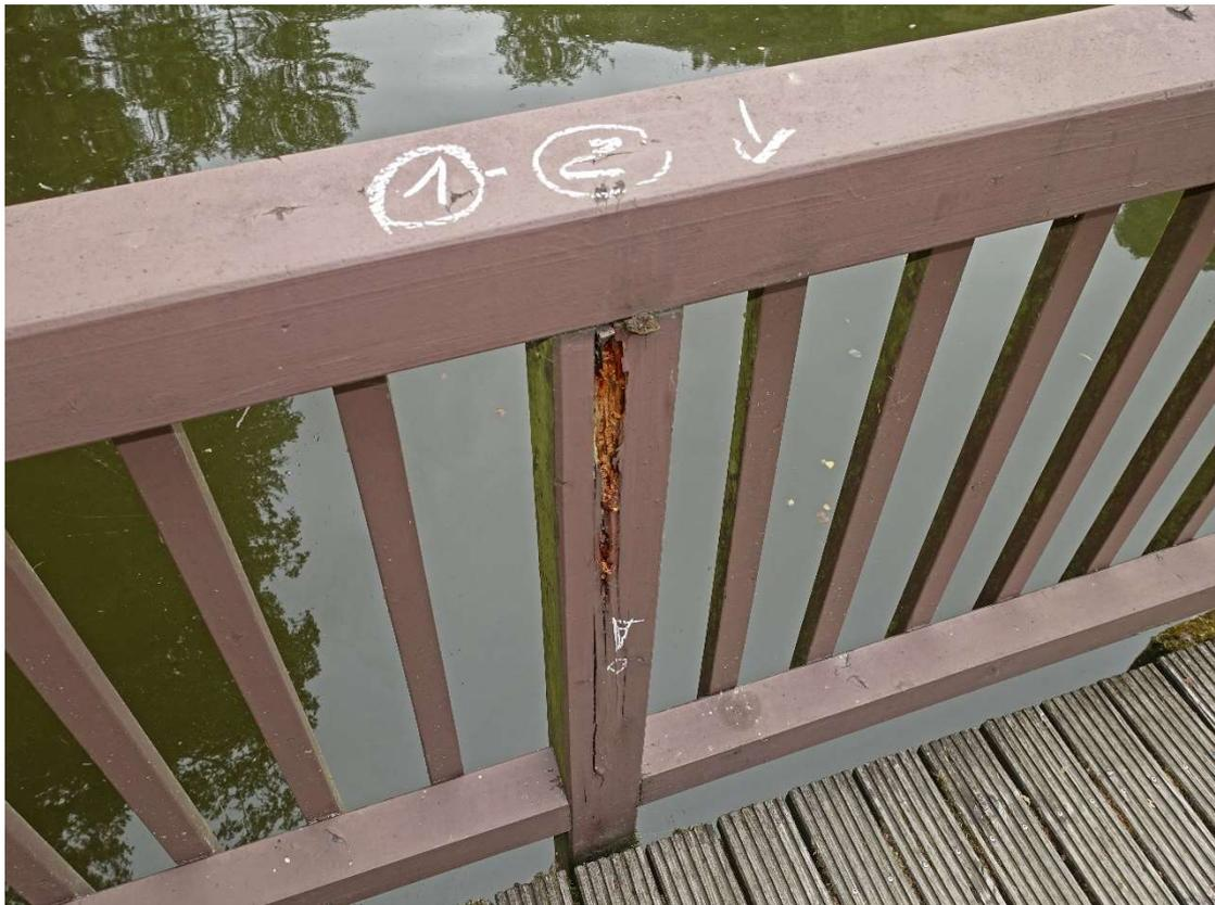
**Bild 9: fortgeschrittener Pilzbefall am Pfosten des Geländers – Achse 1 - 2**
