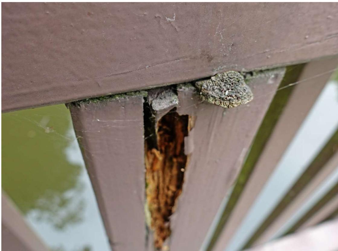
**Bild 10: Pilzfruchtkörper eines Blättlings am Pfosten des Geländers – Achse 1 - 2**
