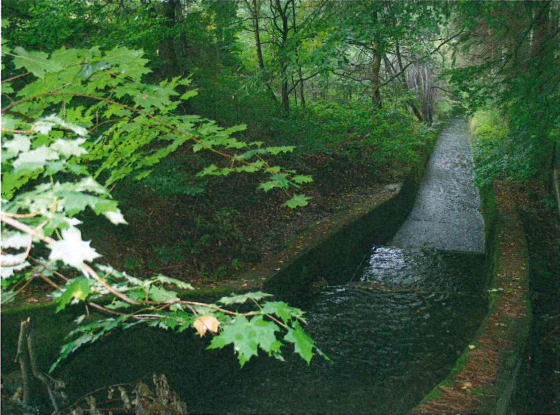
Abb. 2 Ablaufkanal mit drei Stufen
