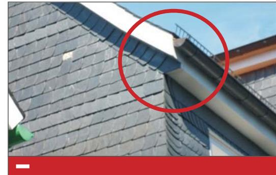
Bild 25: Die Verkröpfung ist entfallen, Traufkasten und Ort-
