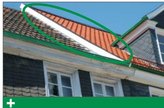
Bild 26 und 27: Beispiel für eine Aufdachdämmung: Der Dachversatz verändert die Optik des durchlaufenden Traufkastens nicht
